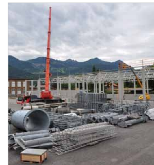
Der Umbau ist in vollem Gange.
