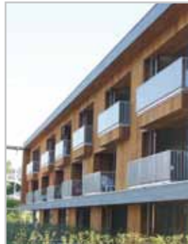
Die Wohnanlage besitzt einen Passivhaus-Standard.
